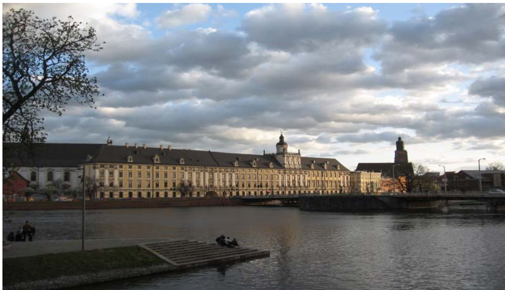
Das Verwaltungsgebäude der Universität, in einem ehemaligen Kloster Mehr dazu (in Englisch): http://international.uni.wroc.pl/en/s3.php
