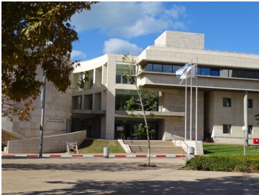
Zentrales Verwaltungsgebäude der TAU
